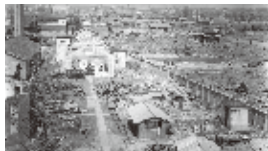
空襲後の工学部付近
